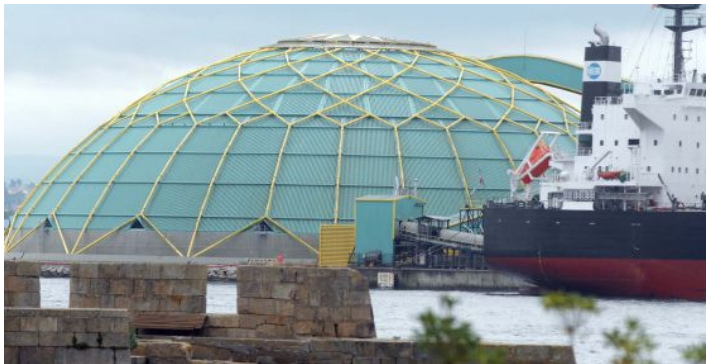
Instalaciones para alojar carbón en el puerto de A Coruña / GABRIEL TIZÓN
